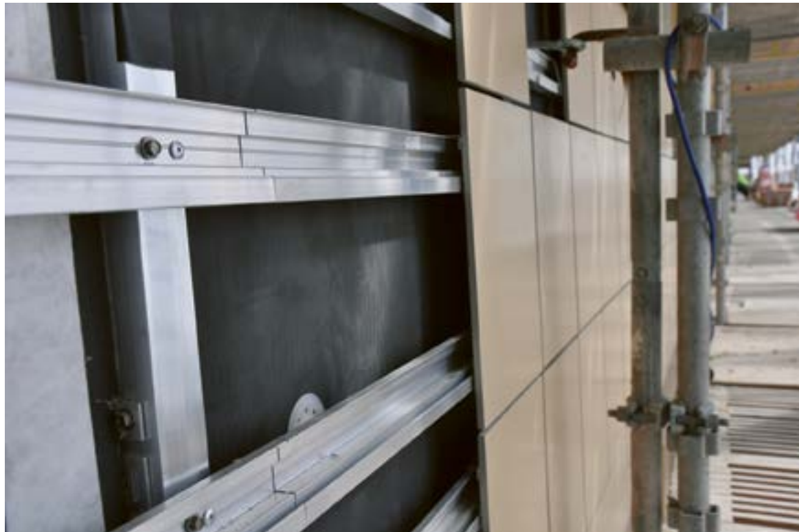
Bild: Svevägen 44, ventilerad fasad dolda clips
